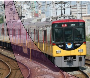
電気鉄道設備
